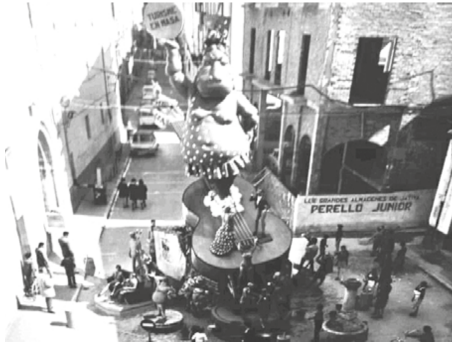
La falla Turisme en massa (Tetuán-Sant Francesc, 1972) fou la primera falla plantada amb grua per l'artista faller Manolo Blanco, qui va recórrer a la grua de la construcció de l'edifici del Quartell i després ser transportada fins la seua ubicació amb l'ajuda d'unes rodes.
